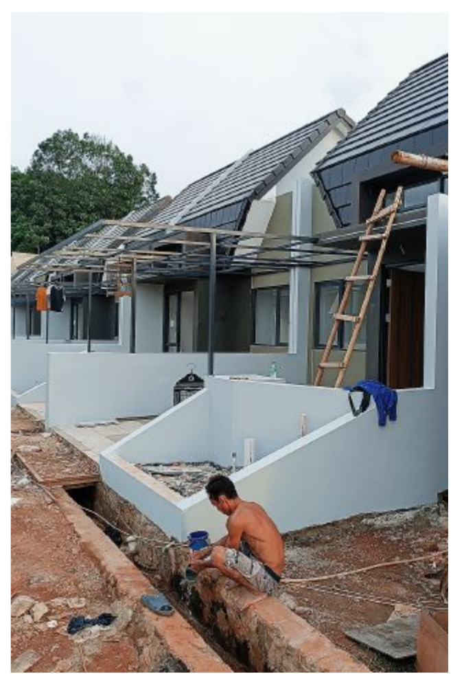
Buruh bangunan beristirahat setelah sehabian mengerjakan pembangunan perumahan baru di kawasan Curug, Depok, Jawa Barat, Rabu (24/1/2024). Skema kredit kepemilikan rumah dengan tenor hingga 35 tahun dinilai menjadi solusi pembiayaan untuk menjangkau rumah yang semakin mahal. Pasar rumah kini didominasi oleh generasi Z.
